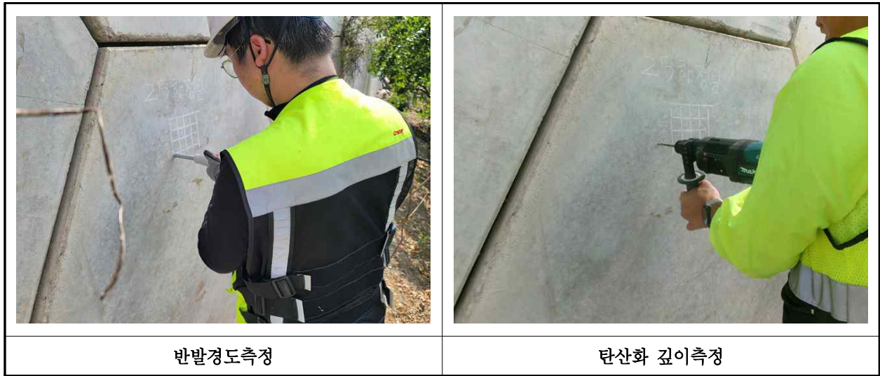
【사진 15.4.1】 재료시험 조사 전경
