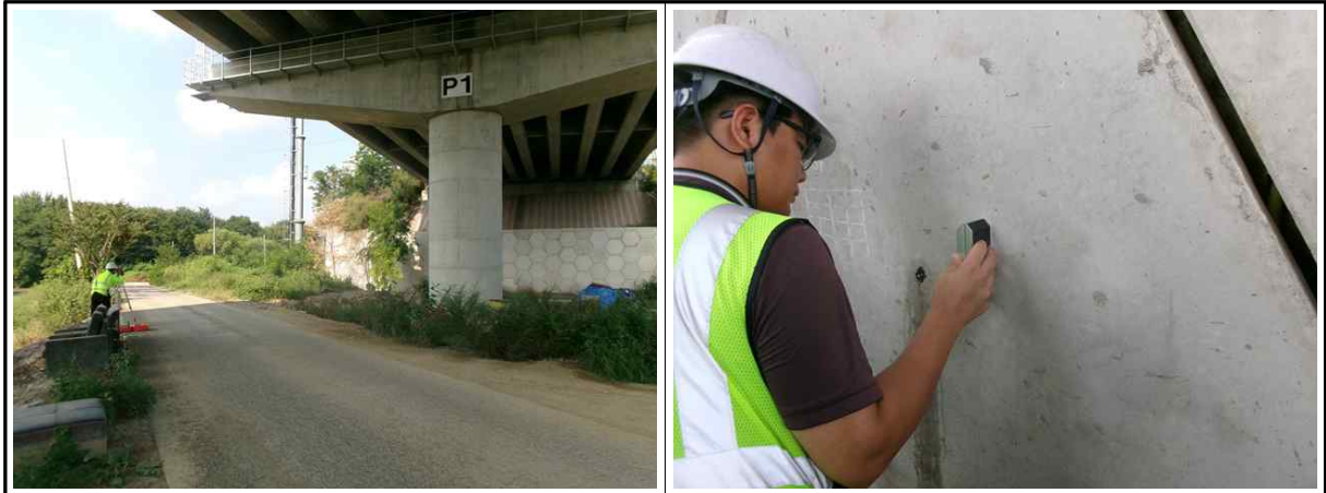
【사진 15.4.2】측량작업 전경
