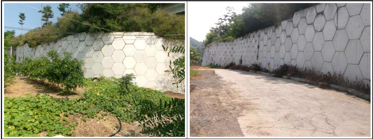
【사진 15.3.1】 지반, 기초부 전경
